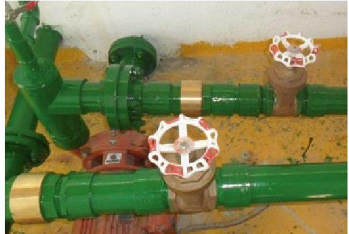
Cambio de válvulas y tubería cuarto de bombas / Costo: \$ 6.959.205
