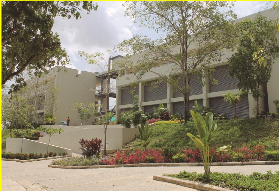
Acceso a nuevos edificios
